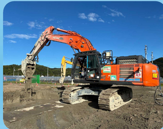
パワーブレンダーによる 中層混合処理工
