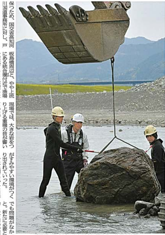
重機でつり上げた岩を川底に埋める。位置を確認し、何度も置き直して固定していく。(香南市土佐山田町戸板島、3月26日午後)
