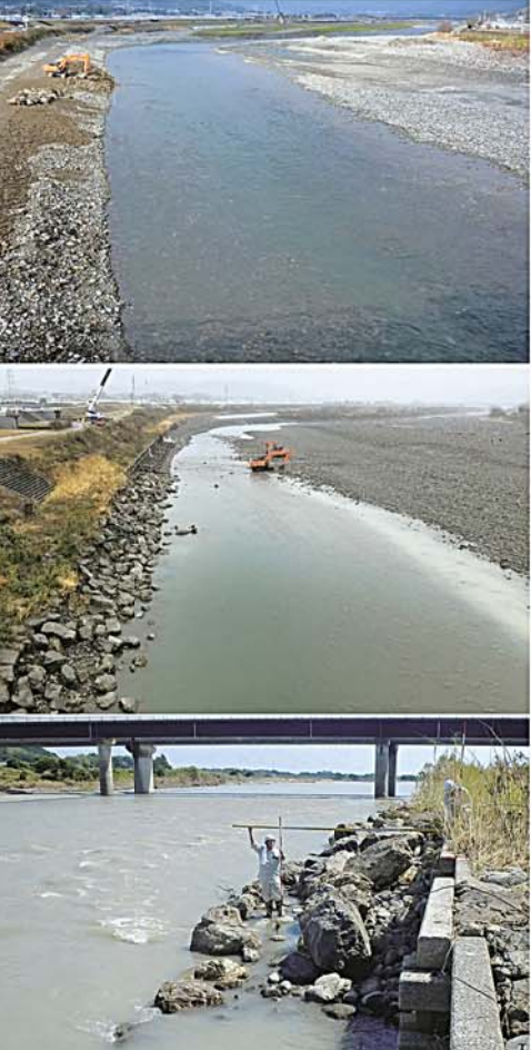
瀬の再生工事の仕上げ直前。すでに川底に石が投入されているが、また自立した変化はないように見える(同、2020年2月14日)。西日本豪雨が川底の凹凸を洗い流し、川の中は中小の石ばかりに、瀬もほとんどなくなっていた(同、2019年2月、有川崇さん提供)。西日本豪雨で被害を受けた直後の物部川の戸板島橋周辺。護岸のために設置されていた大岩が崩れた(2018年7月、国土交通省提供)。
