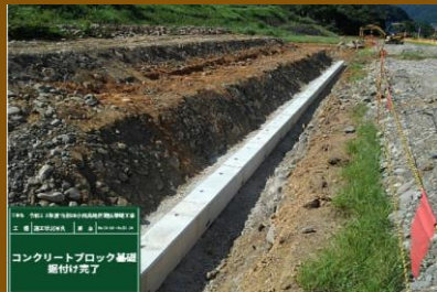
基礎ブロック据付完了
