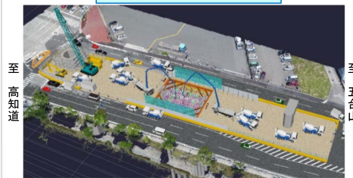
コンクリート打設状況
