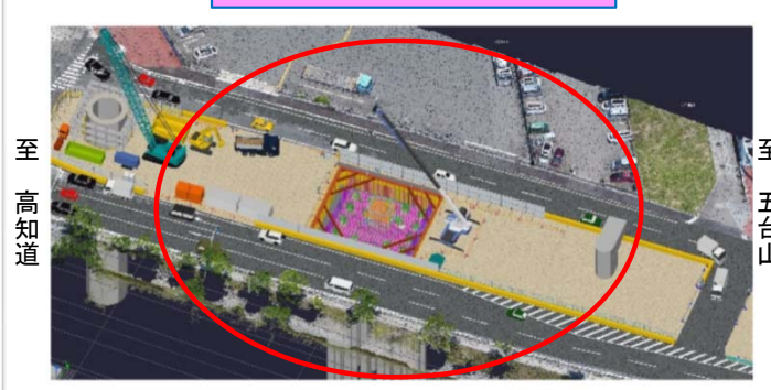
鉄筋組立(底板)状況
