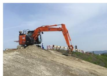
↑マシンガイダンスバックホウを用いた盛土の無丁張施工。
